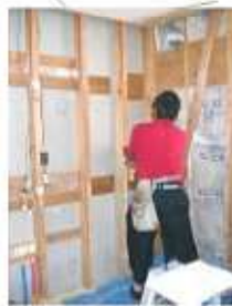
施工中の様子
